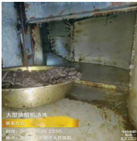
净化器管道内部清洗中
