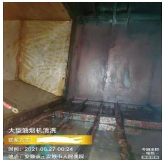
净化器管道内部清洗后
