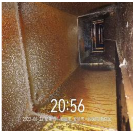
明档管道清洗前
