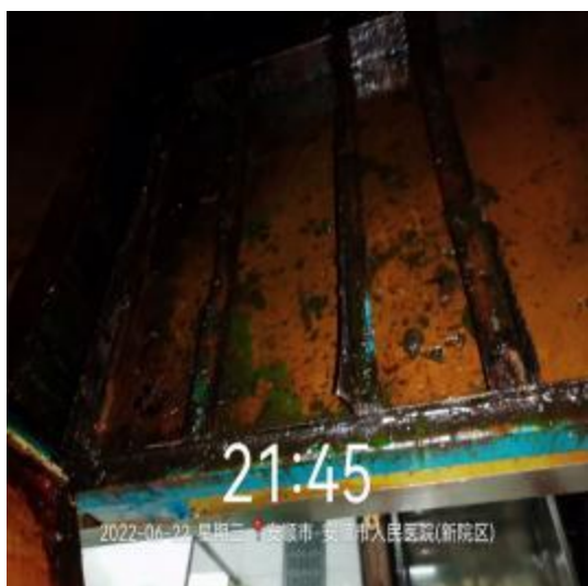
净化器机箱清洗中
