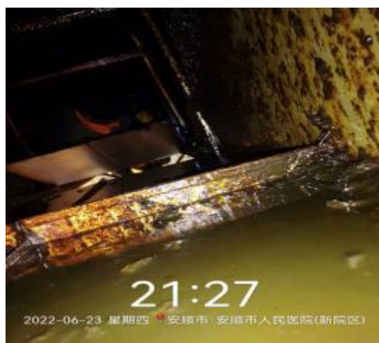
明档管道清洗中
