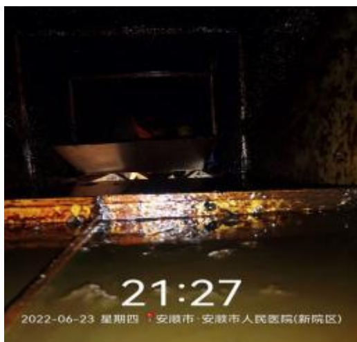
明档管道清洗中
