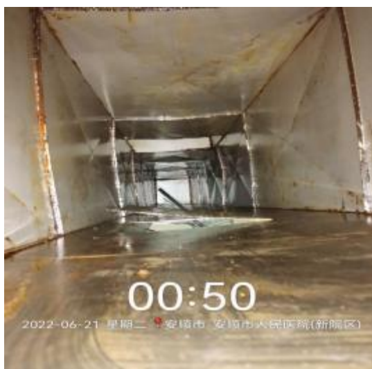
主管道清洗后
