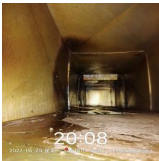
主管道清洗前
