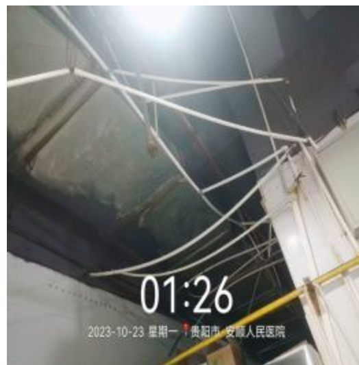
管道线管清洗后
