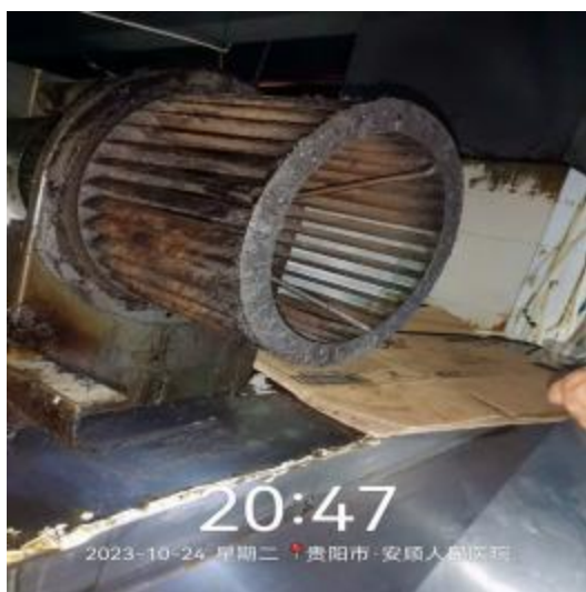
风机叶轮施工中 1
