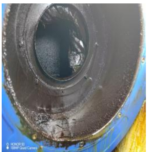
风机机箱清洗前 4
