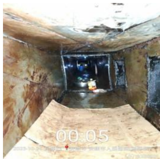
主管道清洗中
