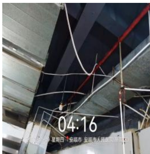
管道线管清洗后
