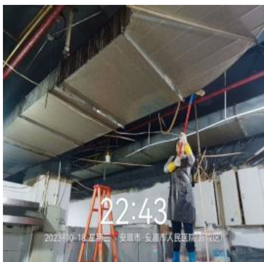
管道线管清洗中
