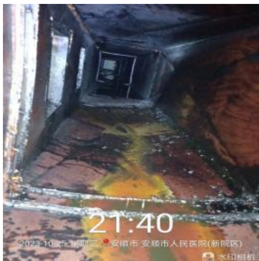
主管道清洗前
