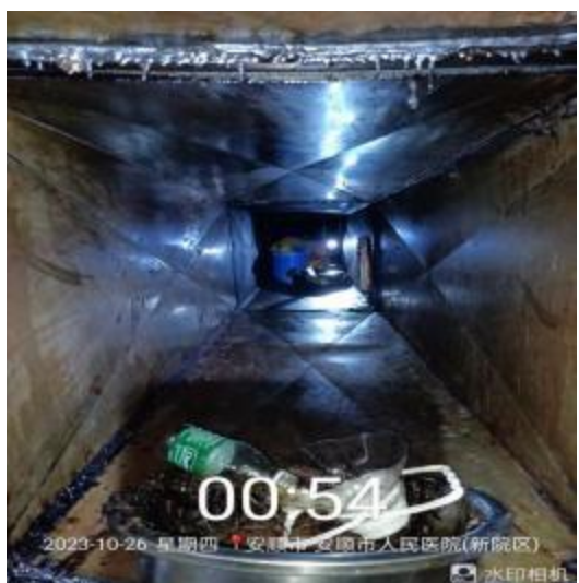
主管道清洗中
