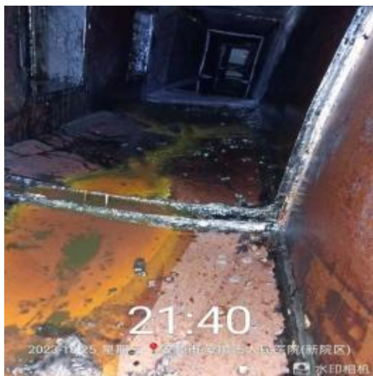
主管道清洗前
