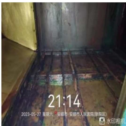
净化器机箱清洗中
