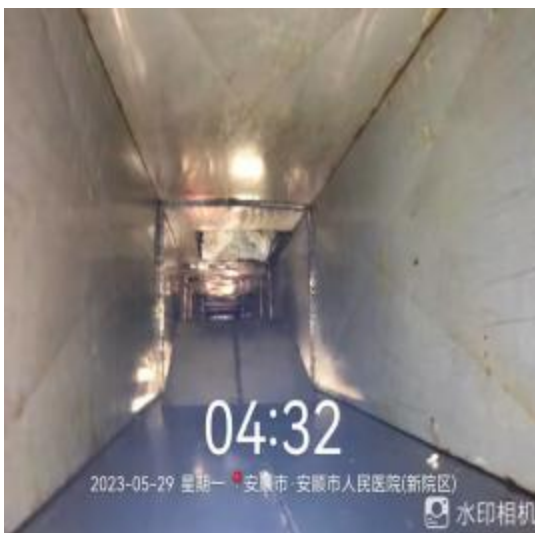
明档管道清洗后
