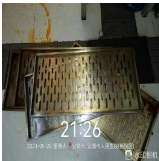
明档防火板清洗前
