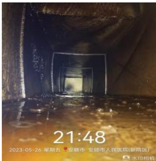
明档管道清洗前
