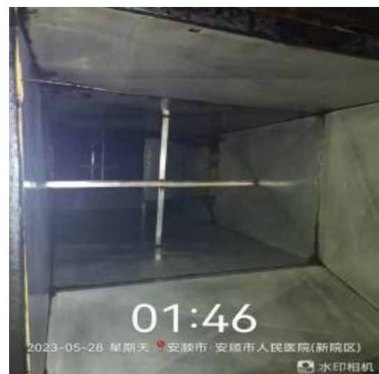
主管道清洗后
