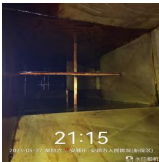
主管道清洗前
