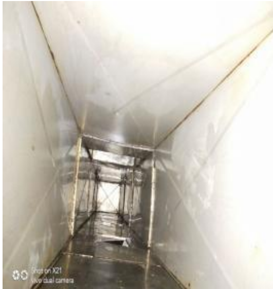
管道清洗前后
