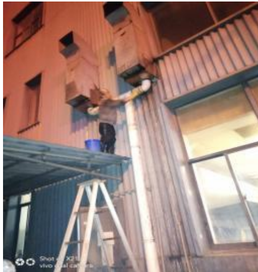
外墙管道施工中
