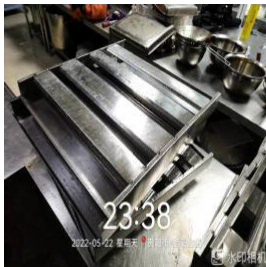
防火板清洗后
