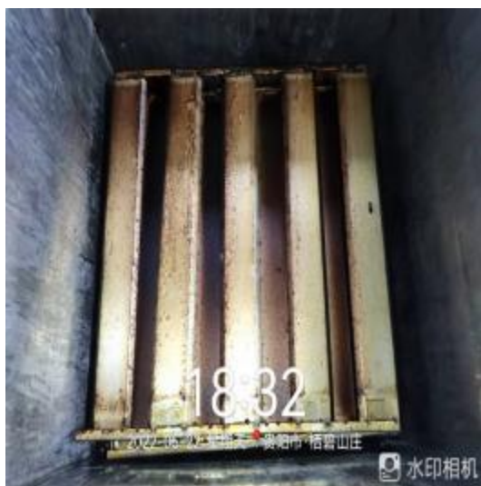
防火板清洗前
