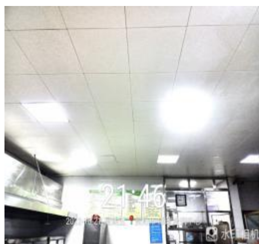
天花板清洗后
