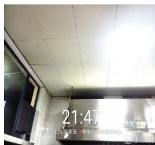
天花板清洗后
