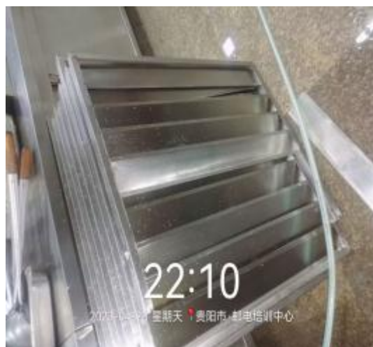
防火板清洗后
