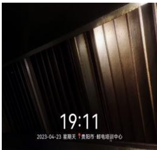
防火板清洗前
