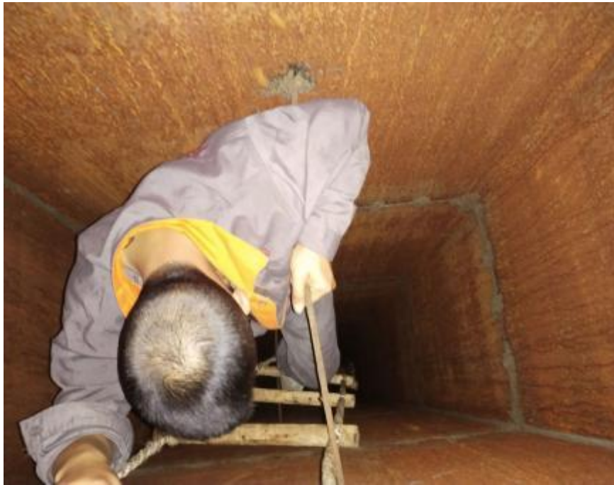
垂直管道施工
