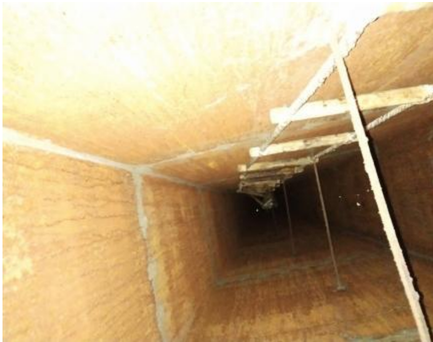
垂直管道施工后
