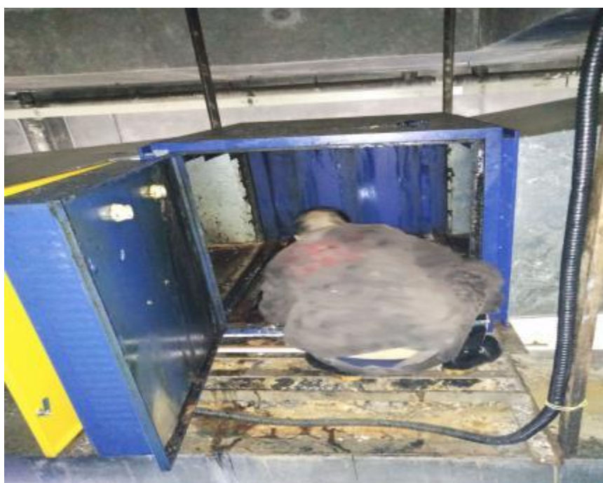
净化器内部施工
