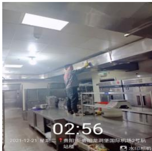
新风管道外观清洗中
