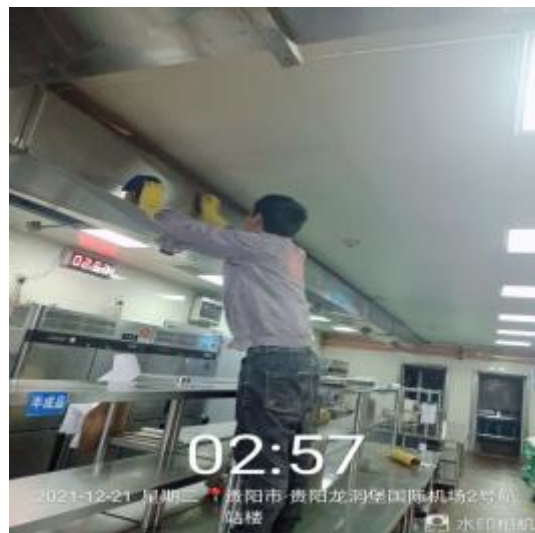
新风管道外观清洗中
