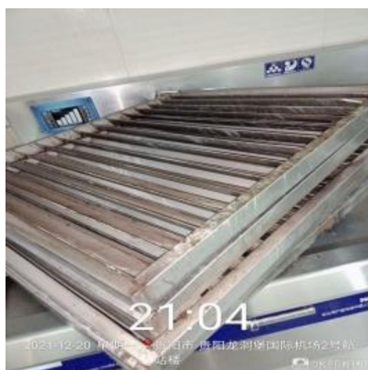
防火板清洗前
