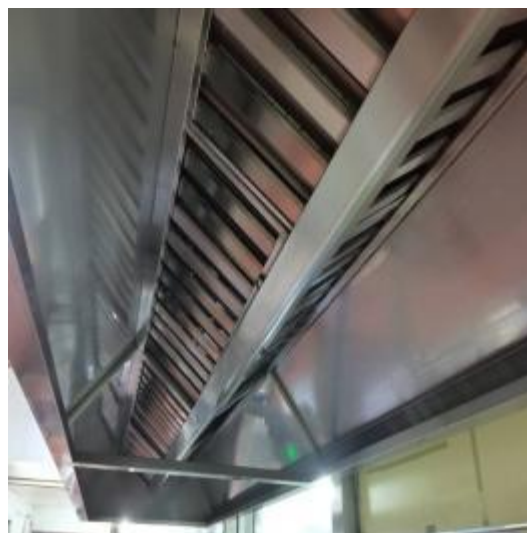
防火板清洗后 2
