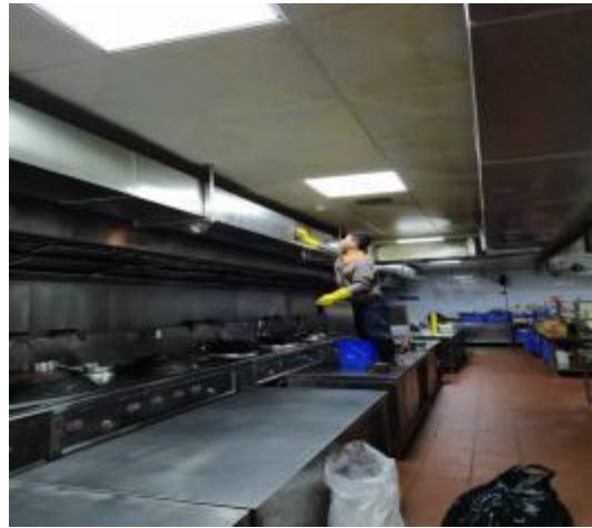
新风管道清洗中
