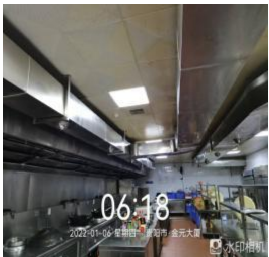
整体厨房清洗后
