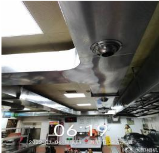
整体厨房管道清洗后
