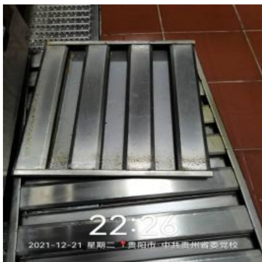
防火板清洗前
