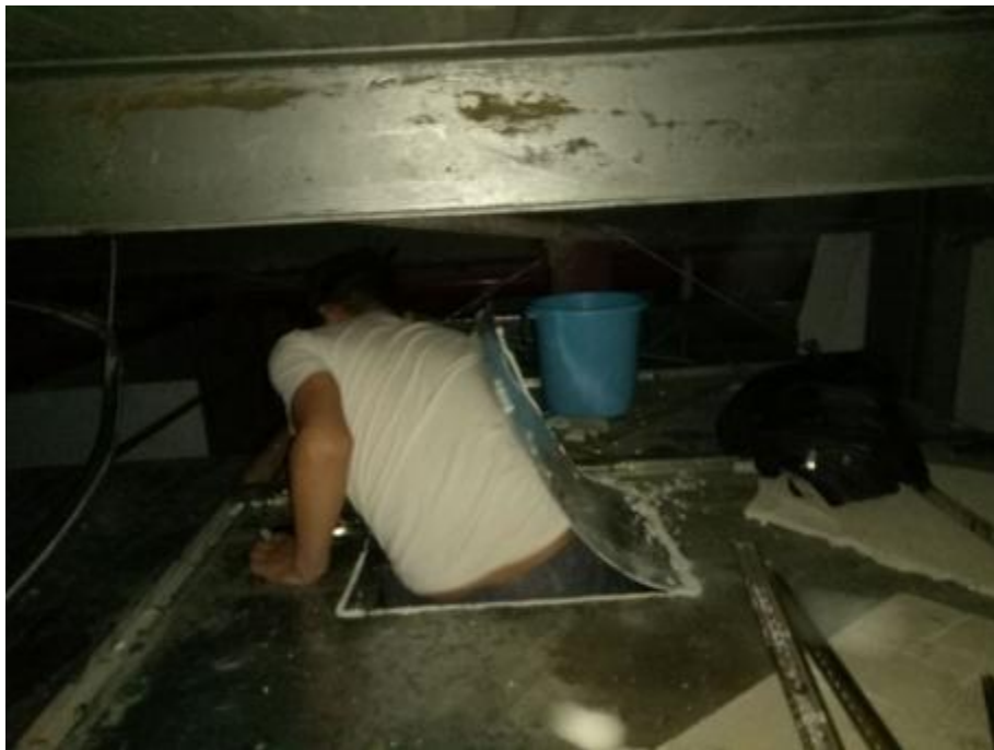
绿茶餐厅和隔离区管道施工
