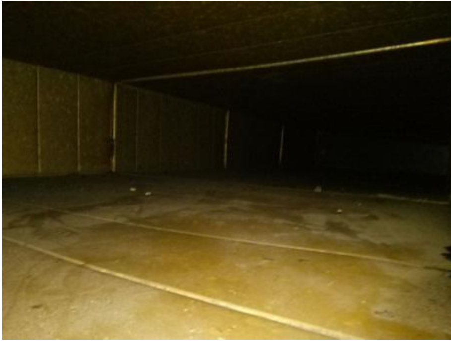
绿茶餐厅和隔离区管道清洗前
