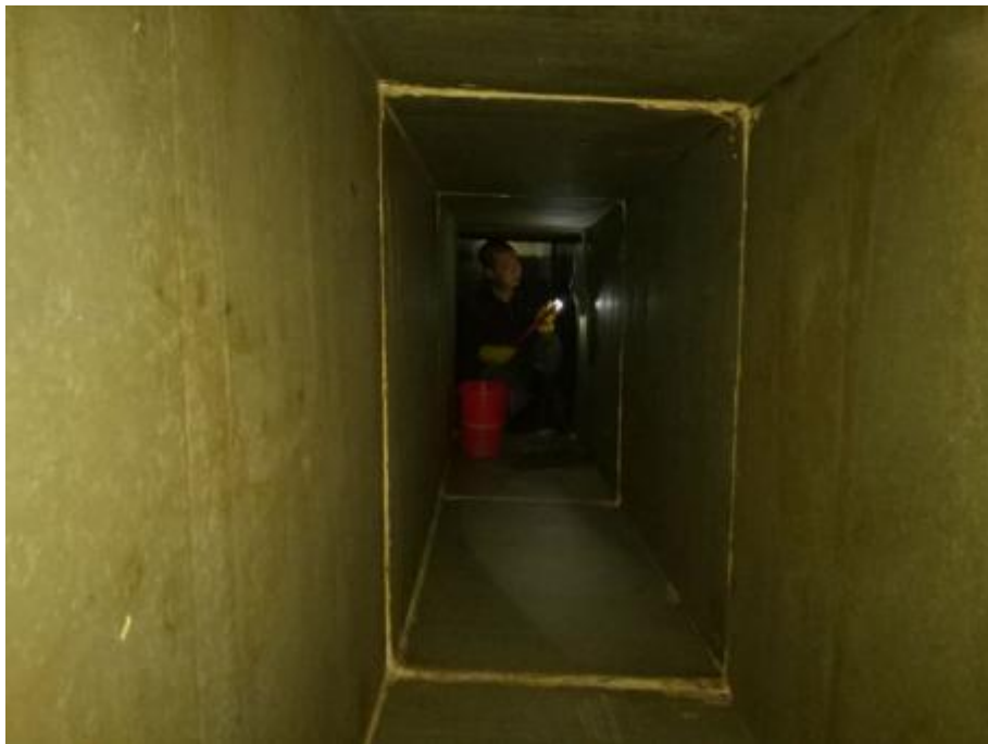
南粉北面+韩香园+香积厨主管施工
