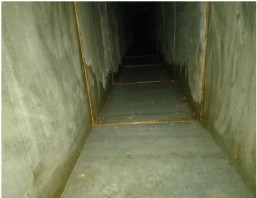
南粉北面+韩香园+香积厨主管段管道清洗后 1
