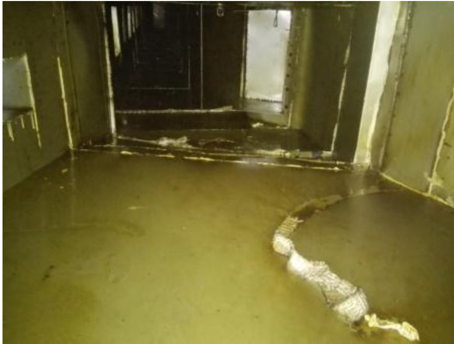
肯德基管道清洗前
