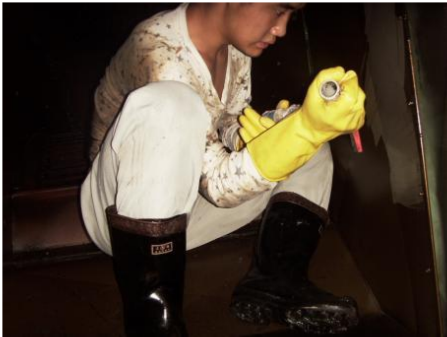
香积厨管道施工
