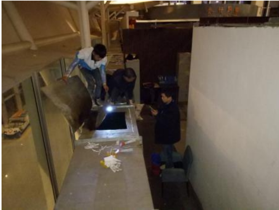
南粉北面+韩香园+香积厨主管施工
