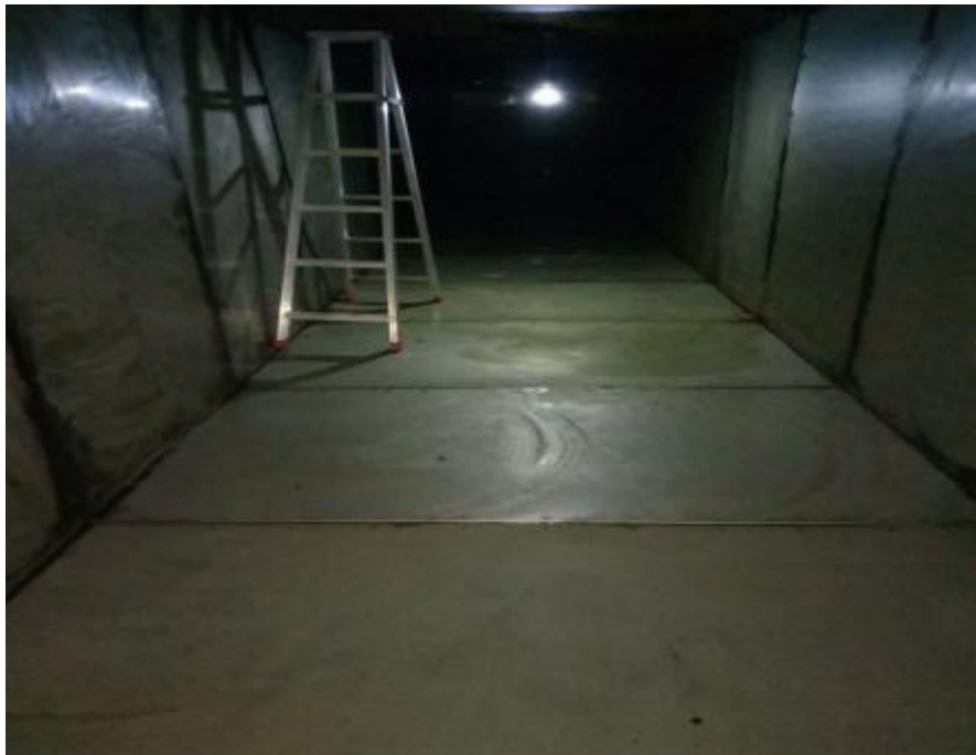
T1、T2 之间排油烟主管道至屋面排放主管清洗后
