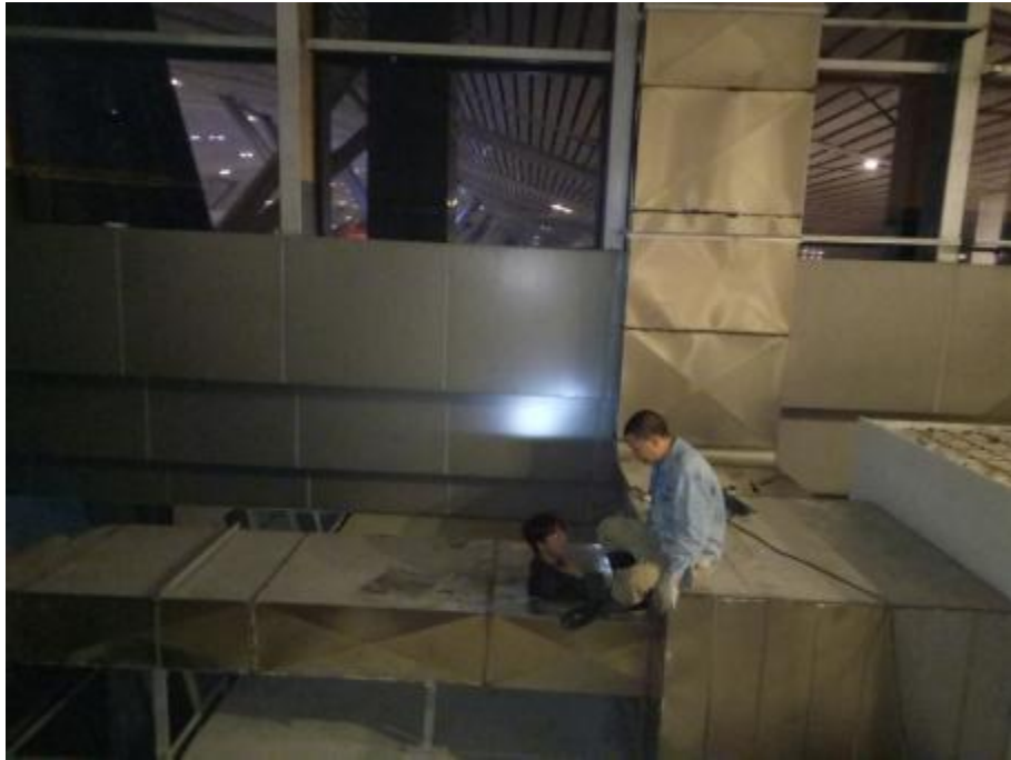
绿茶餐厅和隔离区管道施工
