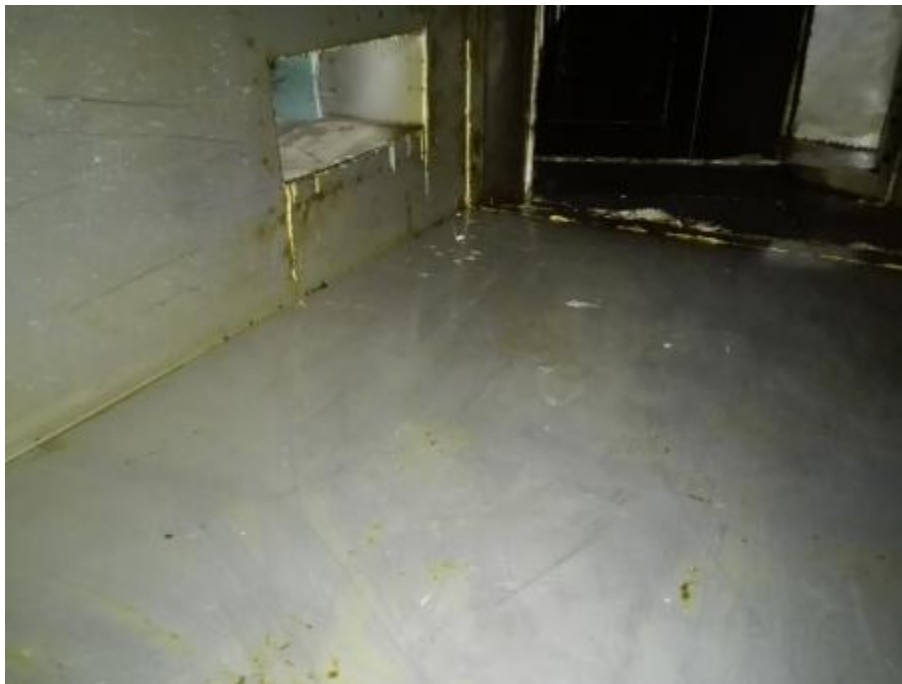
肯德基管道清洗后
