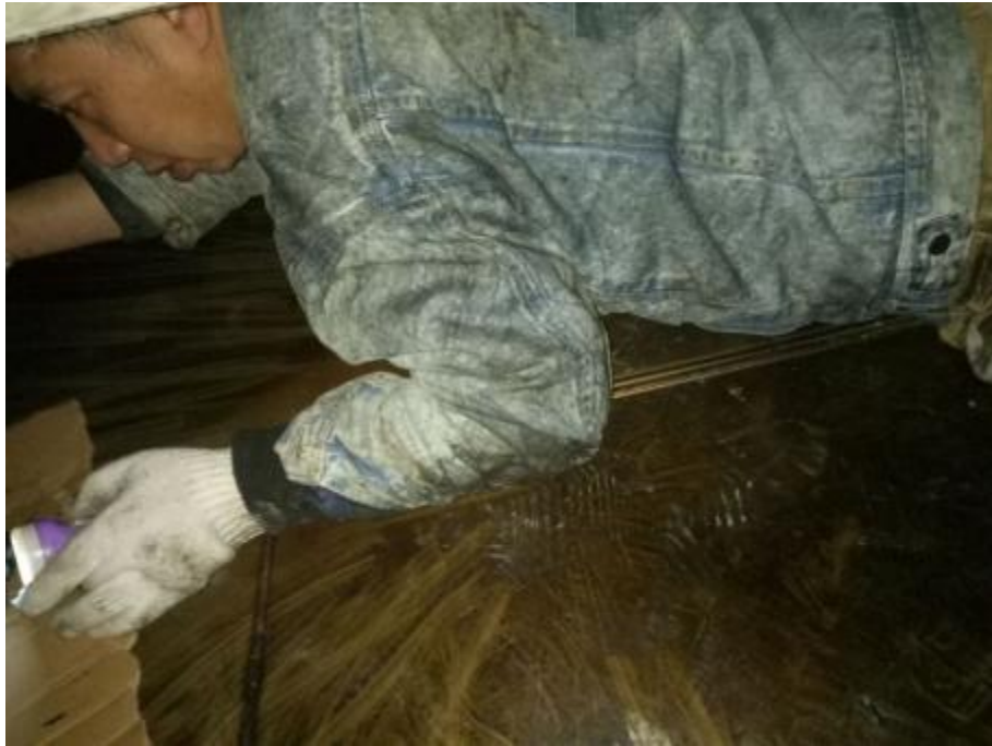
香积厨管道施工
