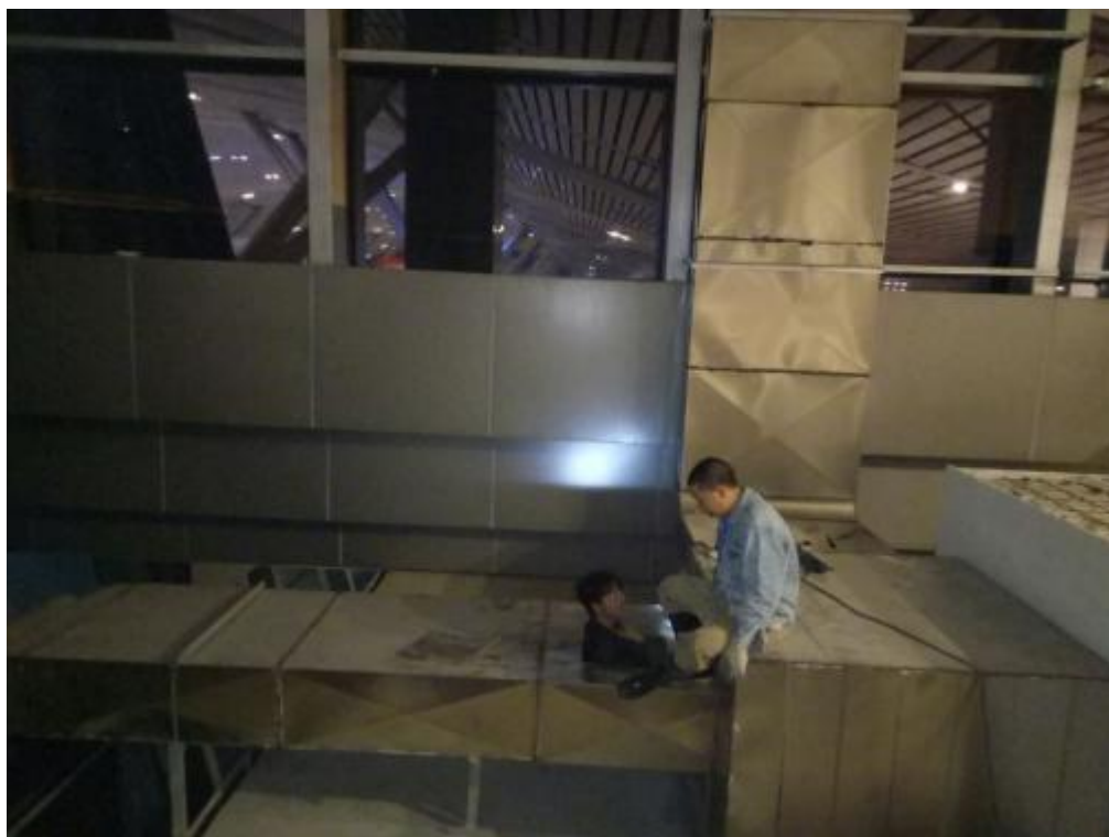
茶餐厅和隔离区管道施工
