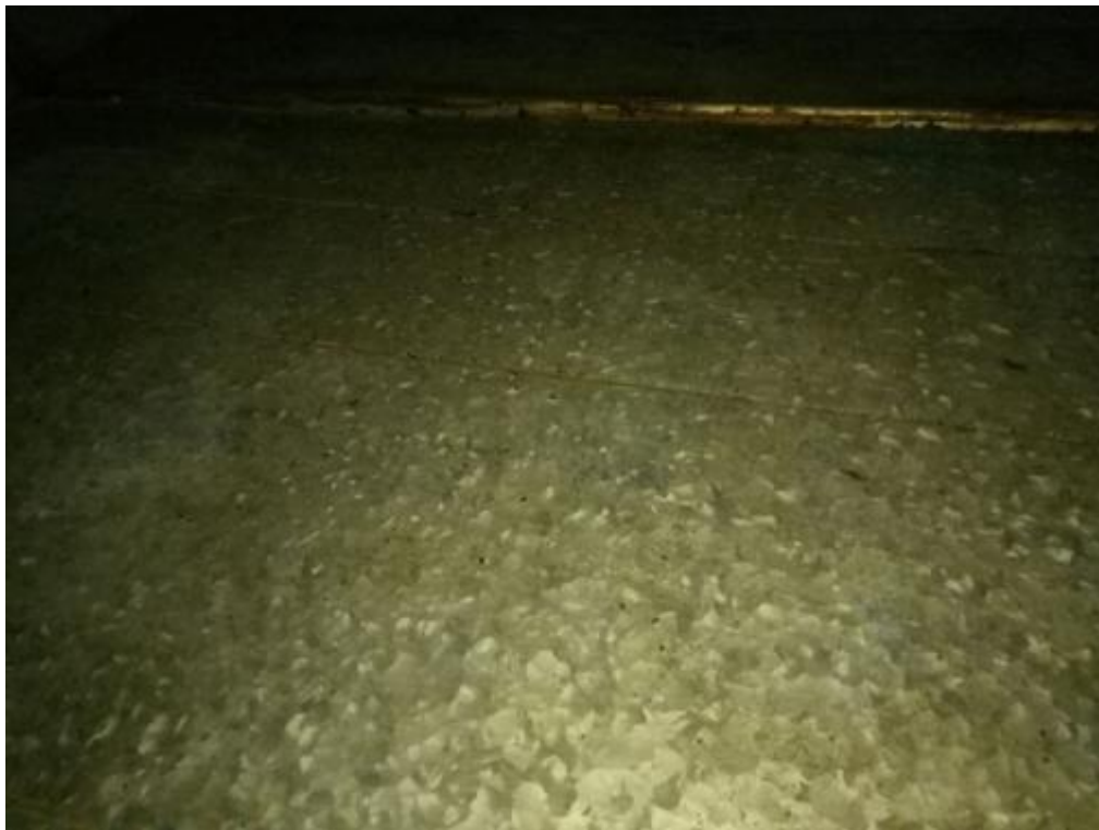
茶餐厅和隔离区管道清洗后
