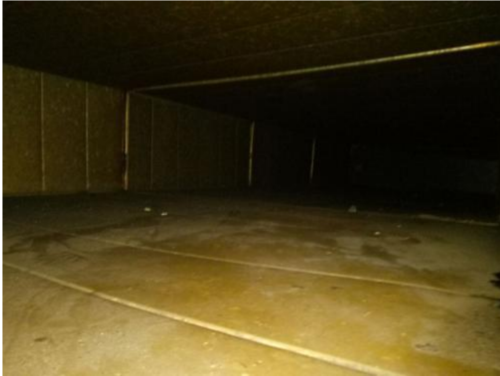
茶餐厅和隔离区管道清洗前
