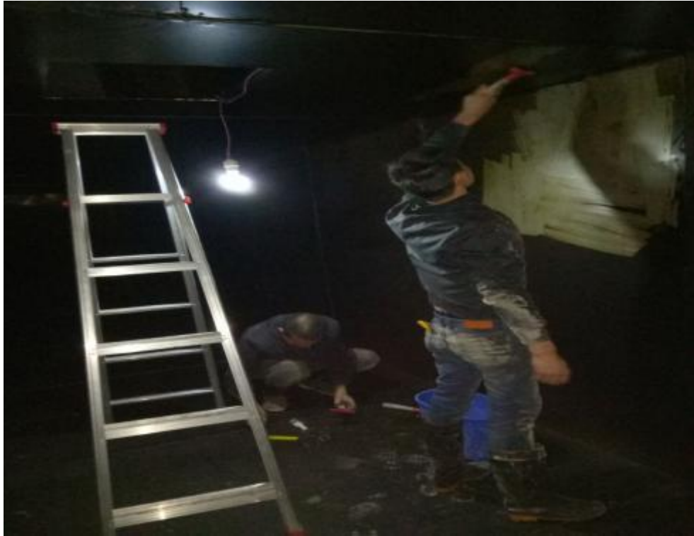
T1、T2 之间排油烟主管道至屋面排放主管清洗前
