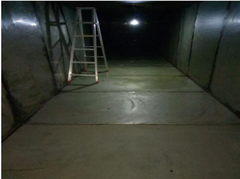
T1、T2 之间排油烟主管道至屋面排放主管清洗后
