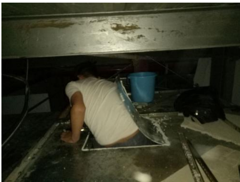
茶餐厅和隔离区管道施工
