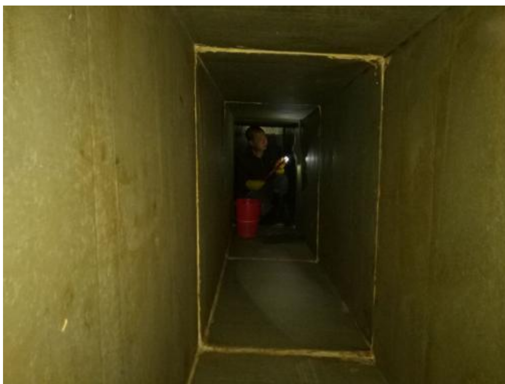
南粉北面+韩香园+香积厨主管施工
