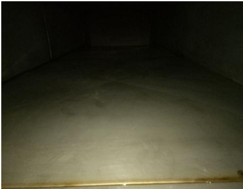
茶餐厅和隔离区管道清洗后 2
