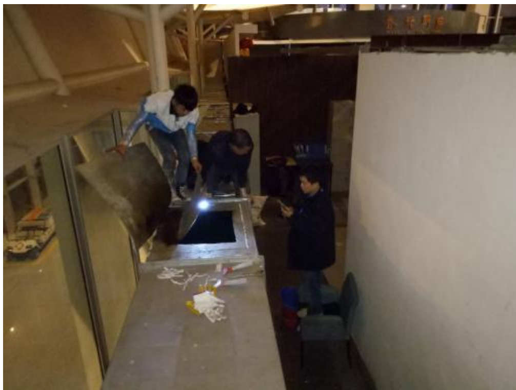
南粉北面+韩香园+香积厨主管施工
