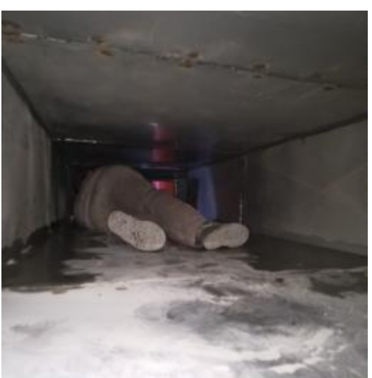
T1 滇记园管道施工 2
