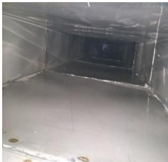
T1 紫悦+贵阳名小吃管道清洗后 1
