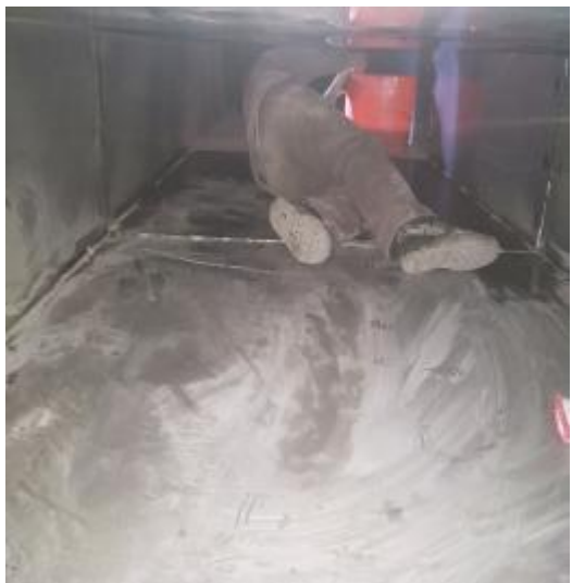
T1 滇记园管道施工 1
