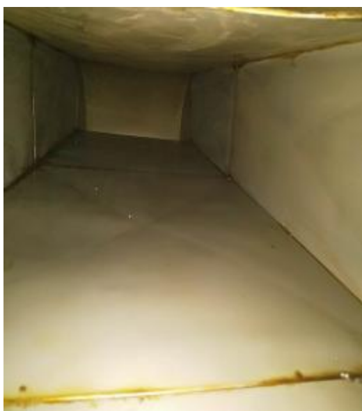
绿茶餐厅快港主管道清洗前 2
