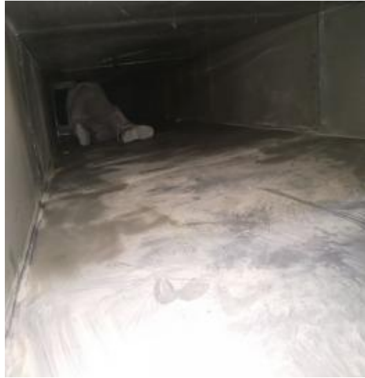
T1 图兰朵管道施工 2
