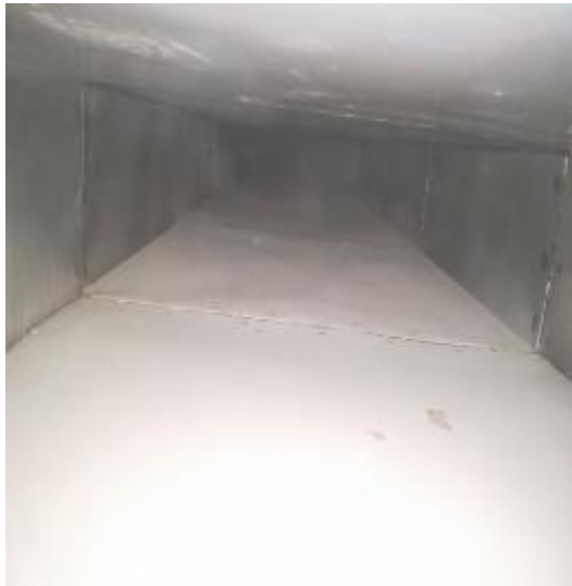
T1 滇记园管道清洗前 1
