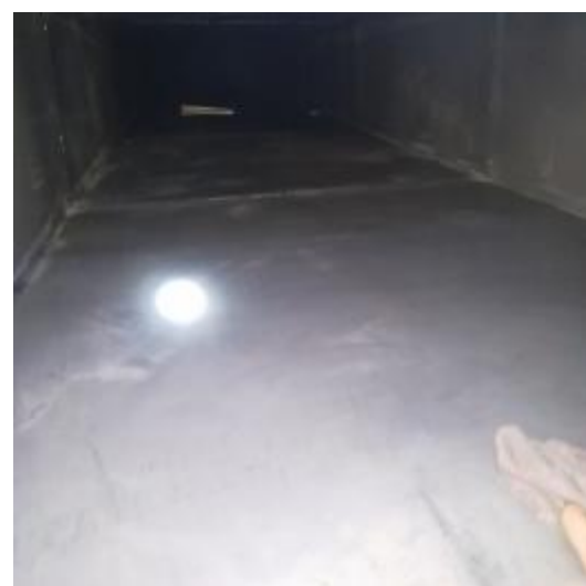
T1 图兰朵管道清洗后 2
