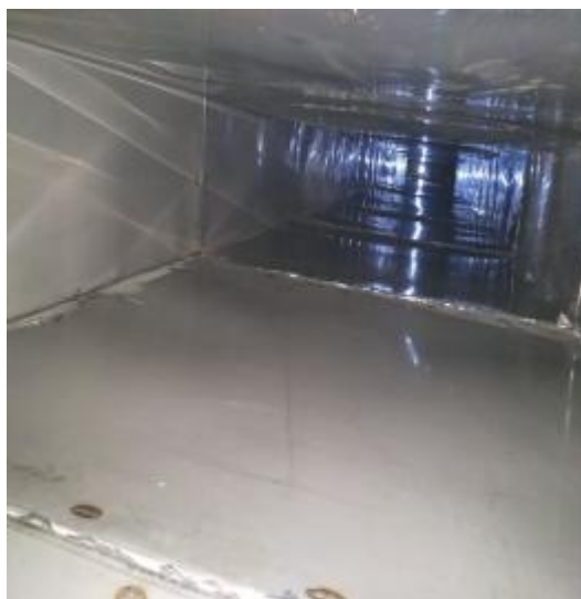
T1 紫悦+贵阳名小吃管道清洗后 2
