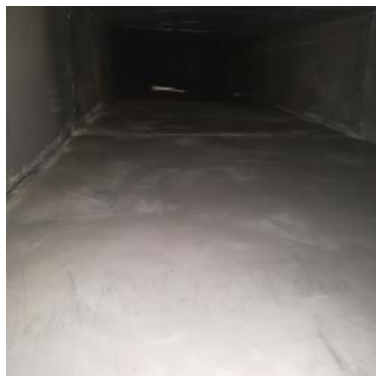
T1 图兰朵管道清洗后
