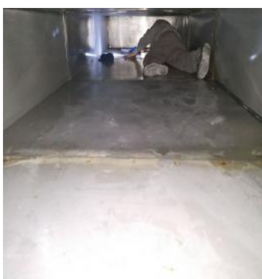
T1 咖啡简餐管道施工中
