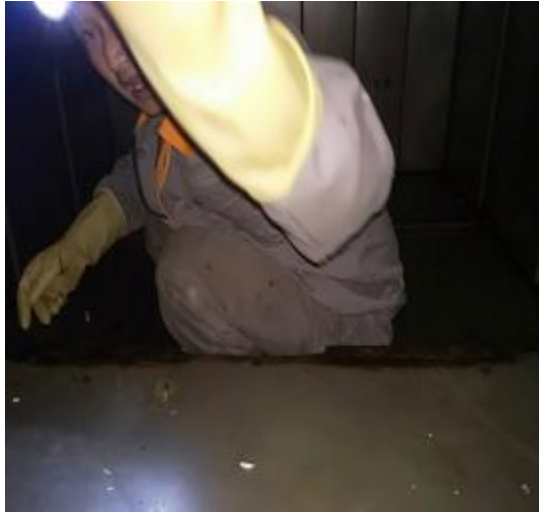
绿茶餐厅快港主管道施工中 1
