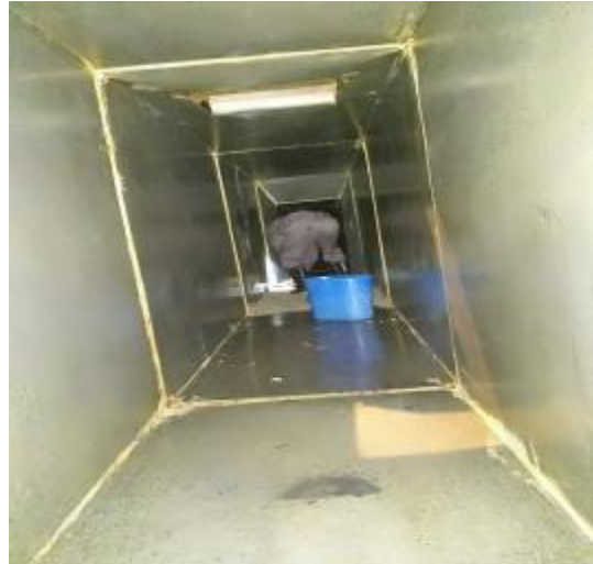
香积厨南粉北面韩香园主管道施工中 2
