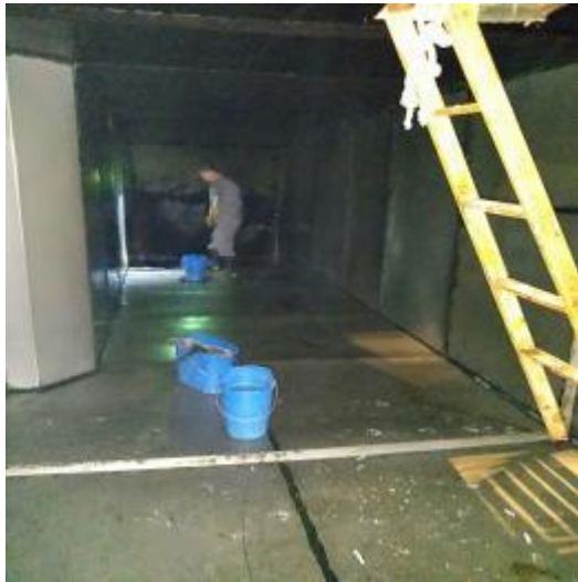
T1T2 主管道清洗前 2
