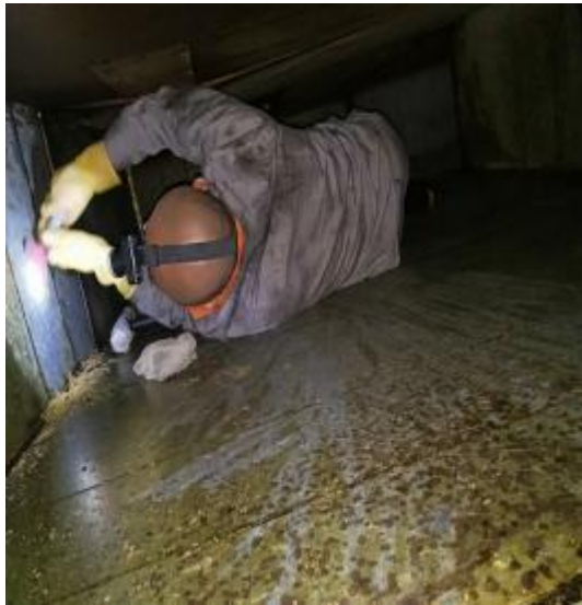
隔离区主管道施工中
