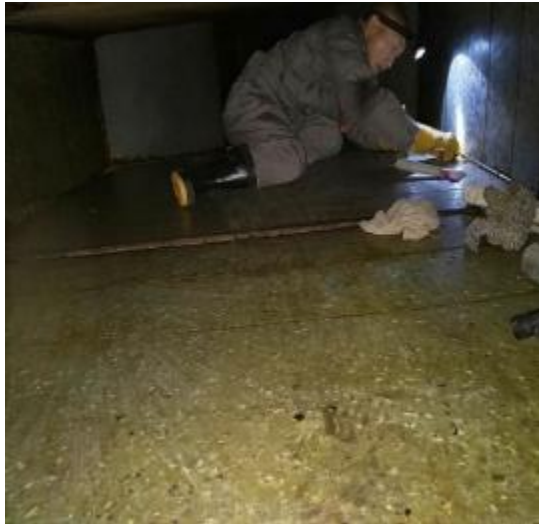
隔离区主管道清洗前
