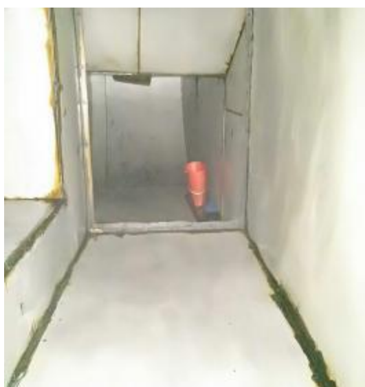
丽港酒店管道清洗后
