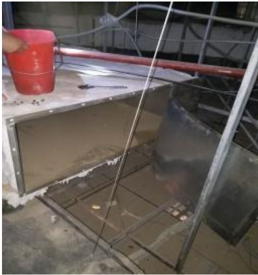
T1 图兰朵管道施工 1
