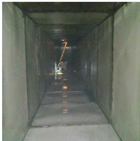
T1T2 主管道施工 2
