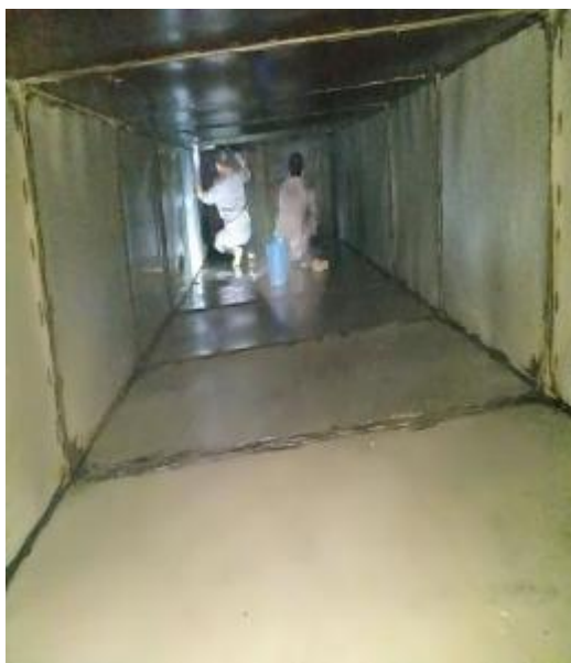
T1T2 主管道清洗前 3
