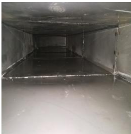
T1 滇记园管道清洗后 1
