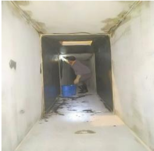
香积厨南粉北面韩香园主管道施工中 1
