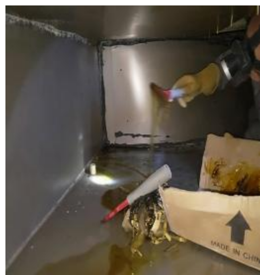
永和豆浆主管道施工中 2
