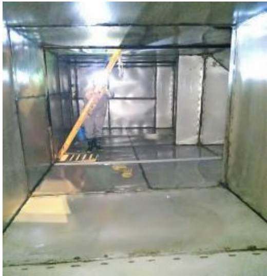
T1T2 主管道施工中 1
