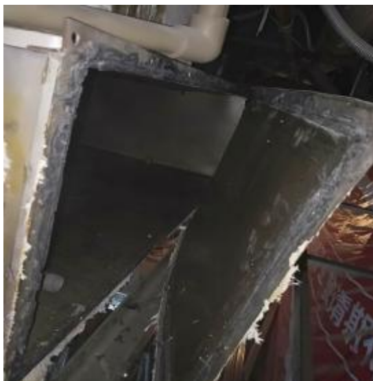
永和豆浆主管道施工中 1
