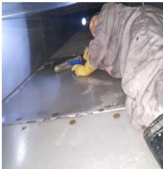
T1 紫悦+贵阳名小吃管道施工 2
