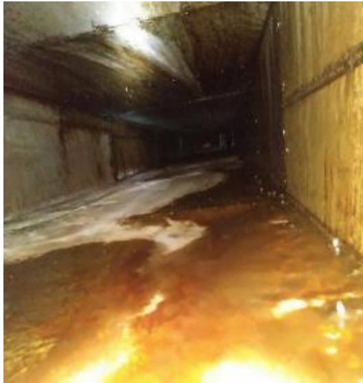
永和豆浆主管道清洗前
