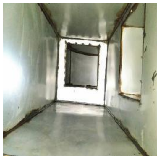
丽港酒店管道清洗后 1
