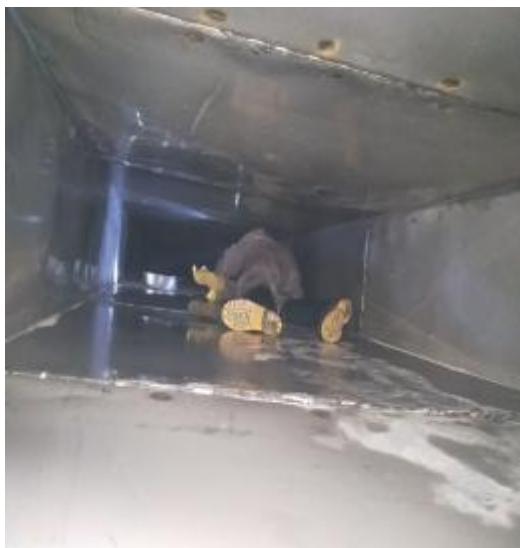
T1 紫悦+贵阳名小吃管道施工 1
