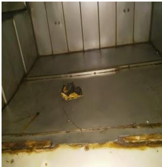
绿茶餐厅快港主管道清洗前 1
