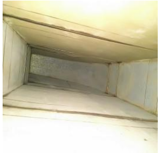
隔离区主管道清洗后
