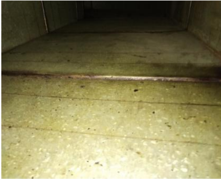
快港主管道清洗前
