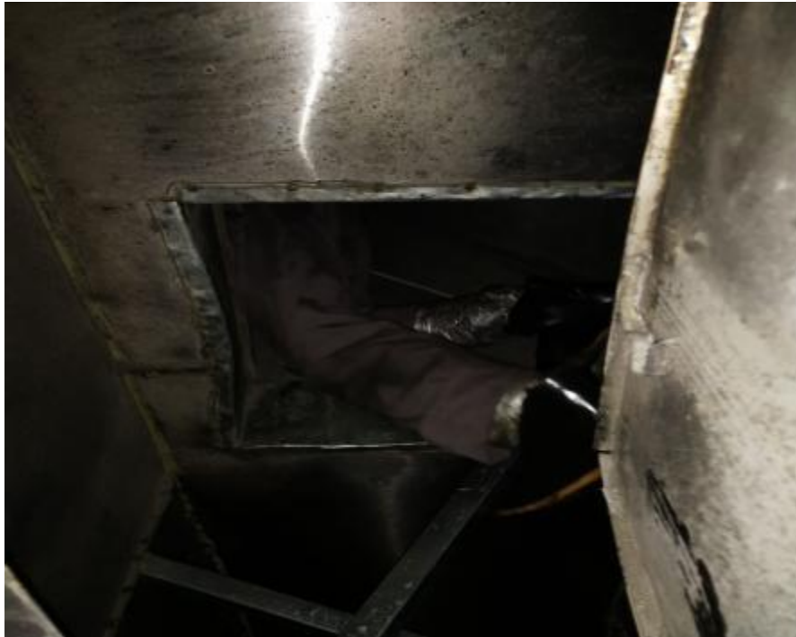
快港主管道施工 1
