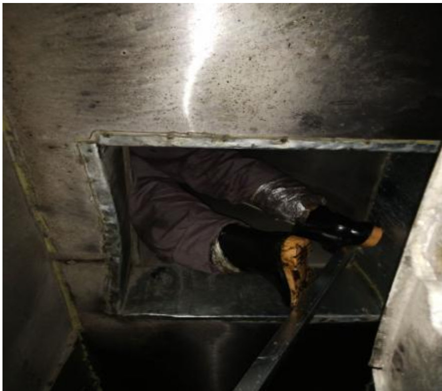
快港主管道施工 2
