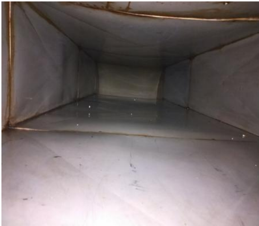
主管道清洗后
