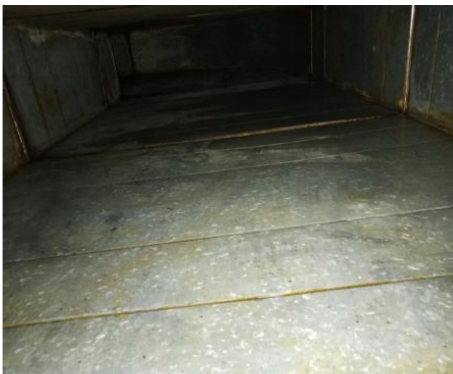
快港主管道清洗后 2
