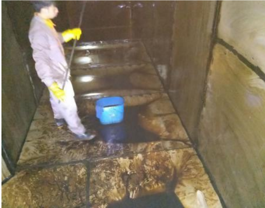
香积厨，南粉北面，汉堡王，主管道施工 1
