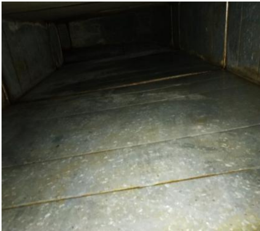
快港主管道清洗后
