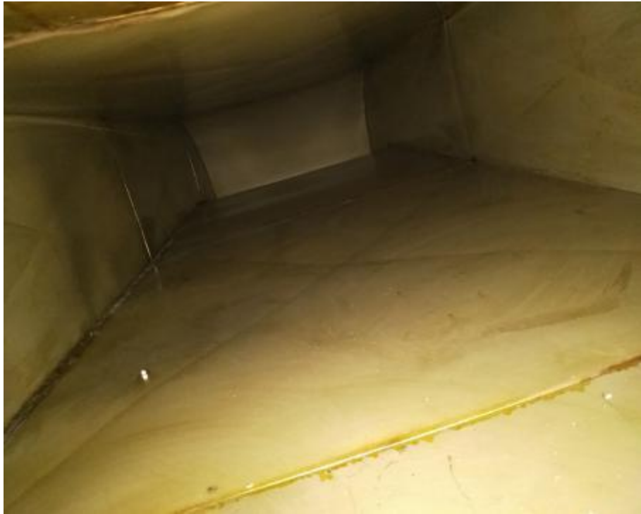
主管道清洗前 1
