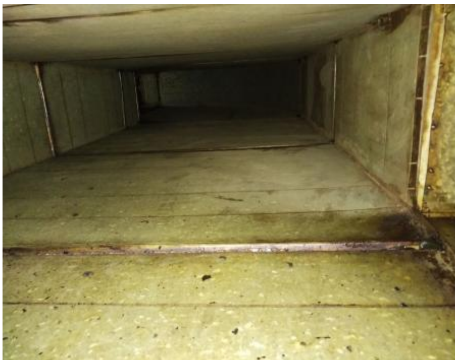
快港主管道清洗前 2
