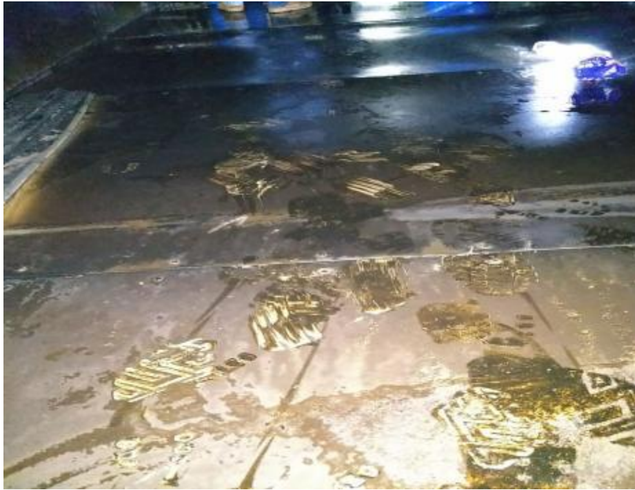
香积厨，南粉北面，汉堡王，主管道清洗前 1
