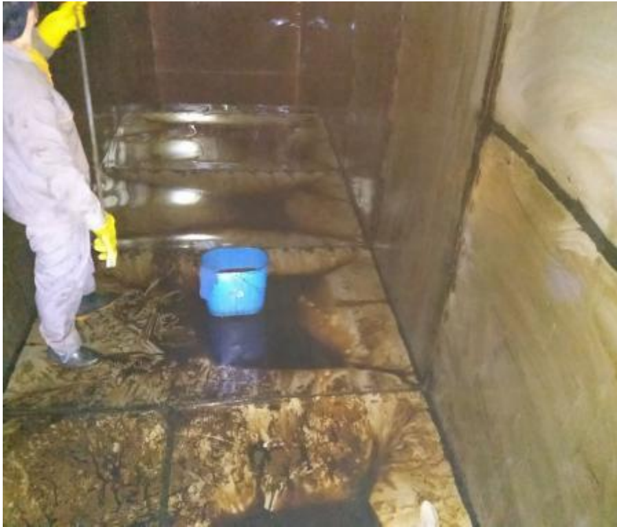
香积厨，南粉北面，汉堡王，主管道清洗前 2
