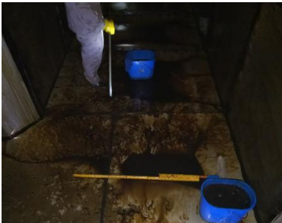
香积厨，南粉北面，汉堡王，主管道施工 2
