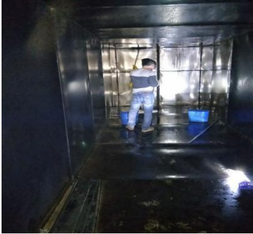
香积厨，南粉北面，汉堡王，主管道施工 3
