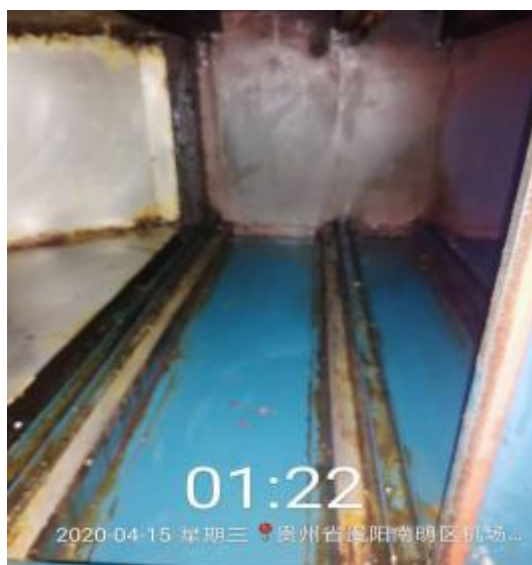
净化器内部清洗后
