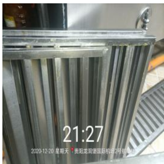
防火板清洗前
