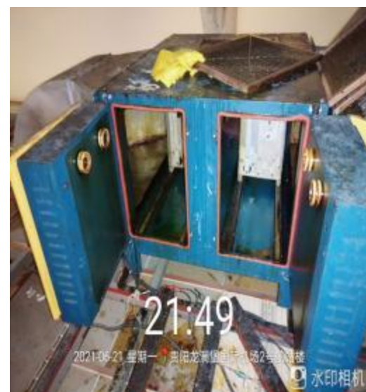
净化器机箱施工中
