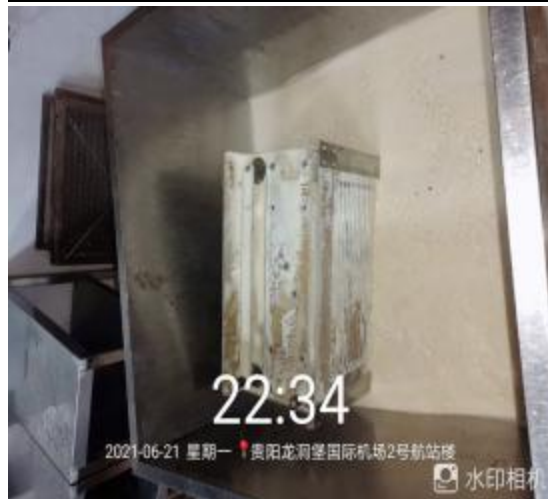
净化器施工中
