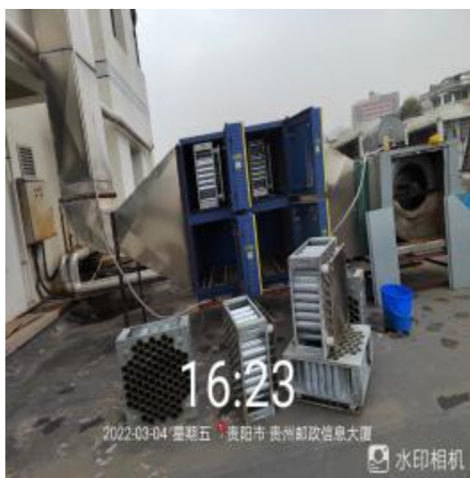
六楼净化器施工中
