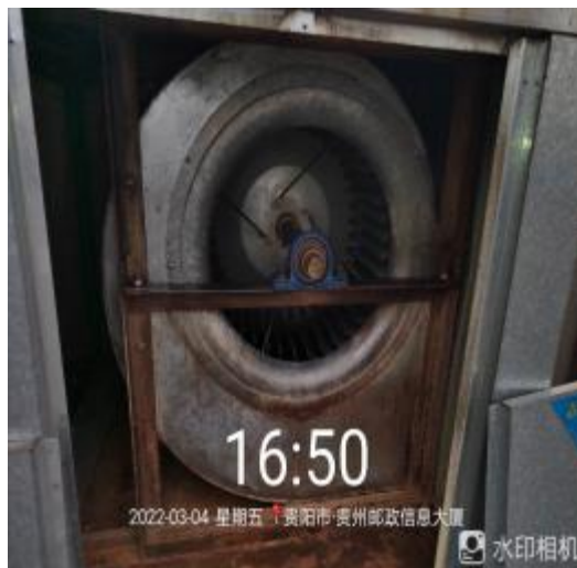
六楼风机施工中
