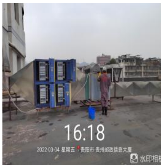
六楼净化器施工中
