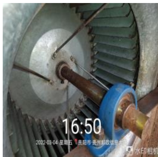
六楼风机清洗后
