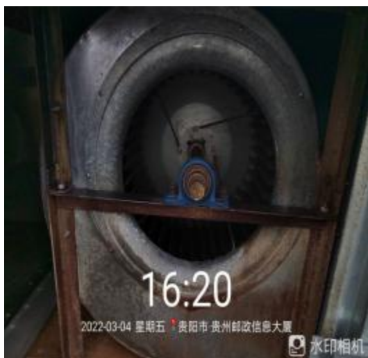
六楼风机施工中
