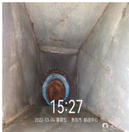
风机管道清洗后
