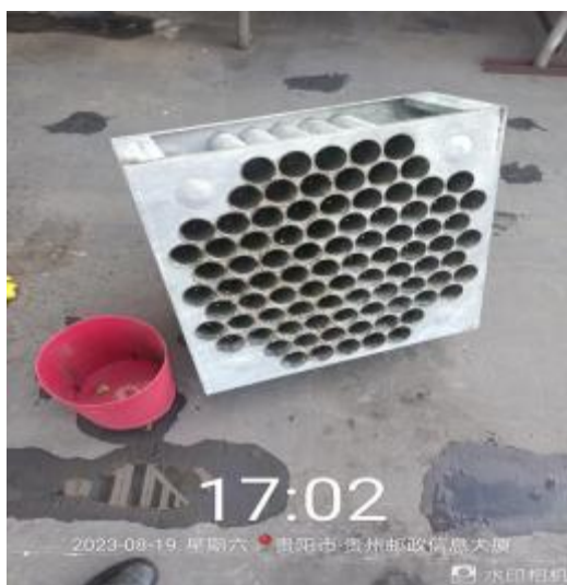
六楼净化器清洗后
