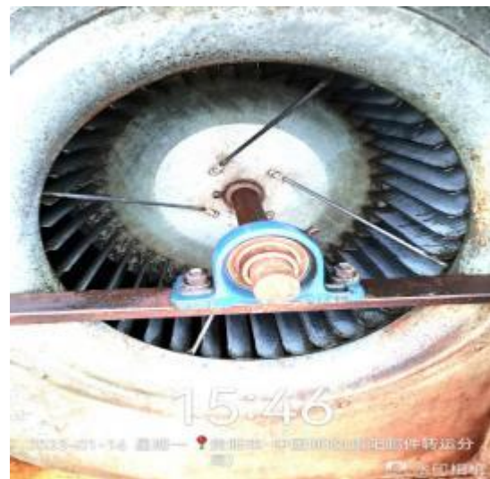
六楼风机清洗后
