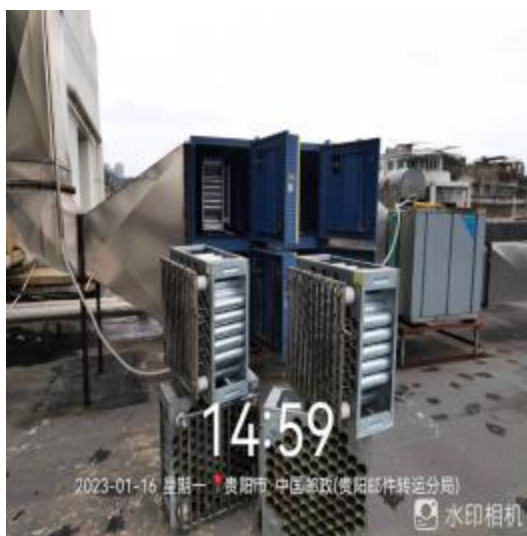
六楼净化器施工中
