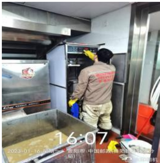
运水控制箱施工中
