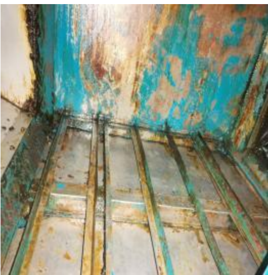
净化器机箱清洗后
