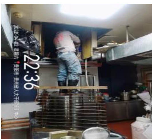
净化器施工中
