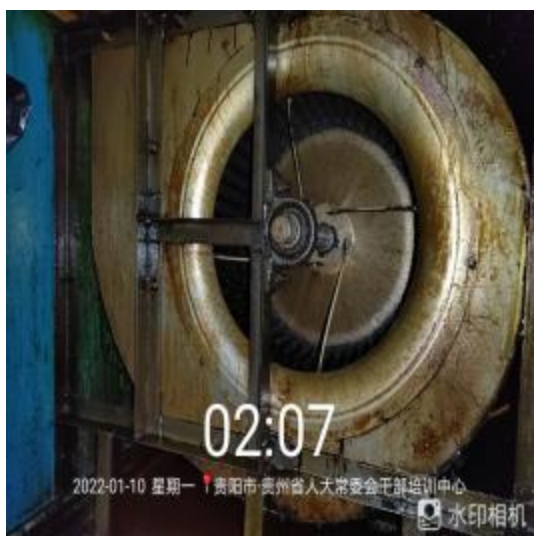
净化器施工中
