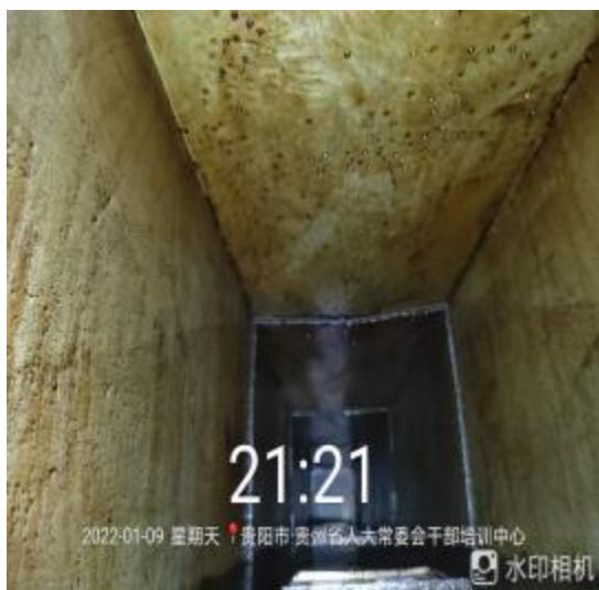
防火板清洗前
