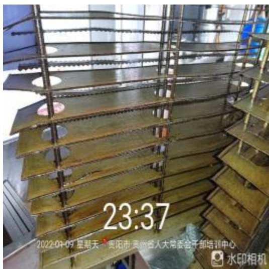
净化器过滤芯清洗前
