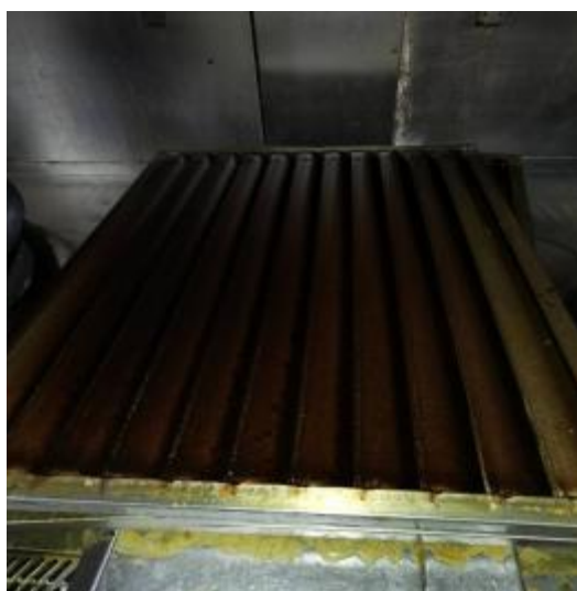
防火板清洗前
