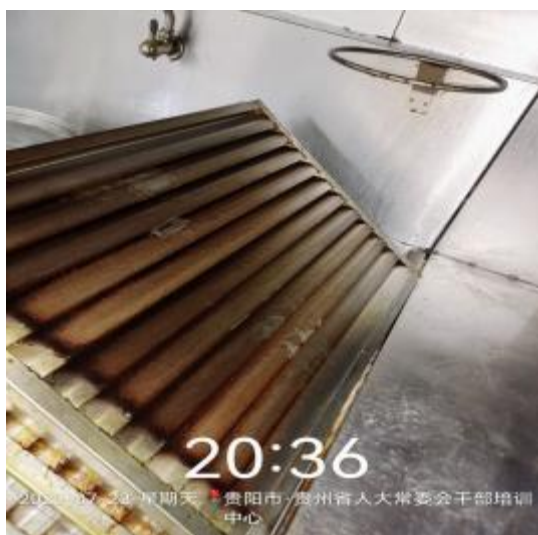
防火板清洗中
