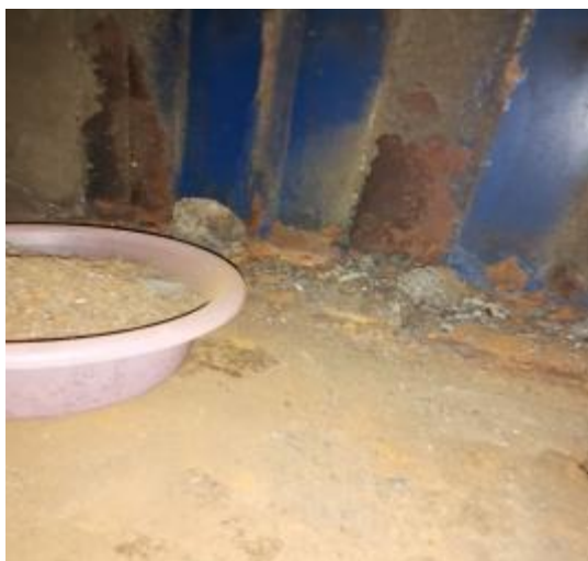
净化器机箱施工中
