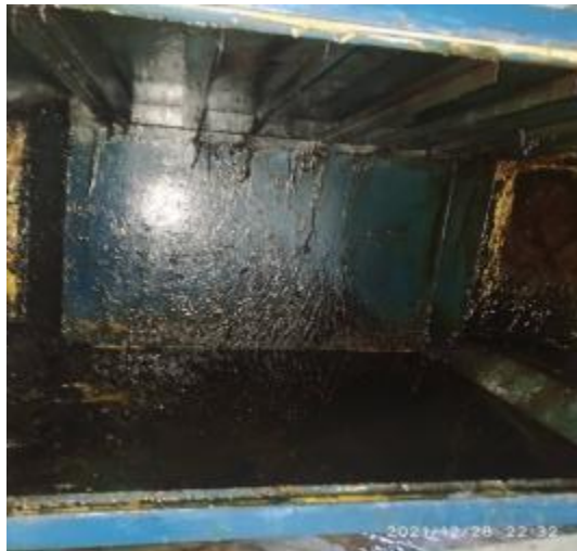
净化器机箱施工中
