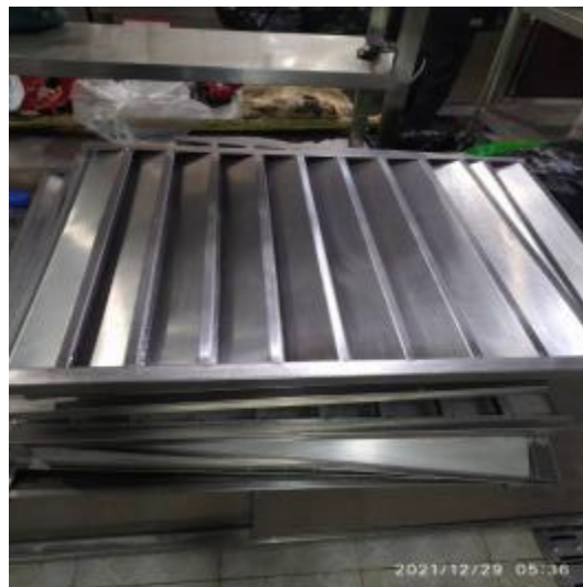
防火板清洗后
