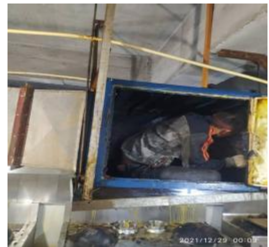
净化器机箱施工中
