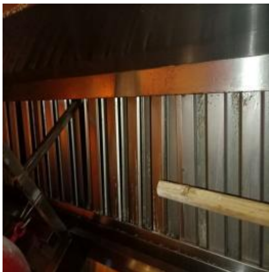
防火板清洗前
