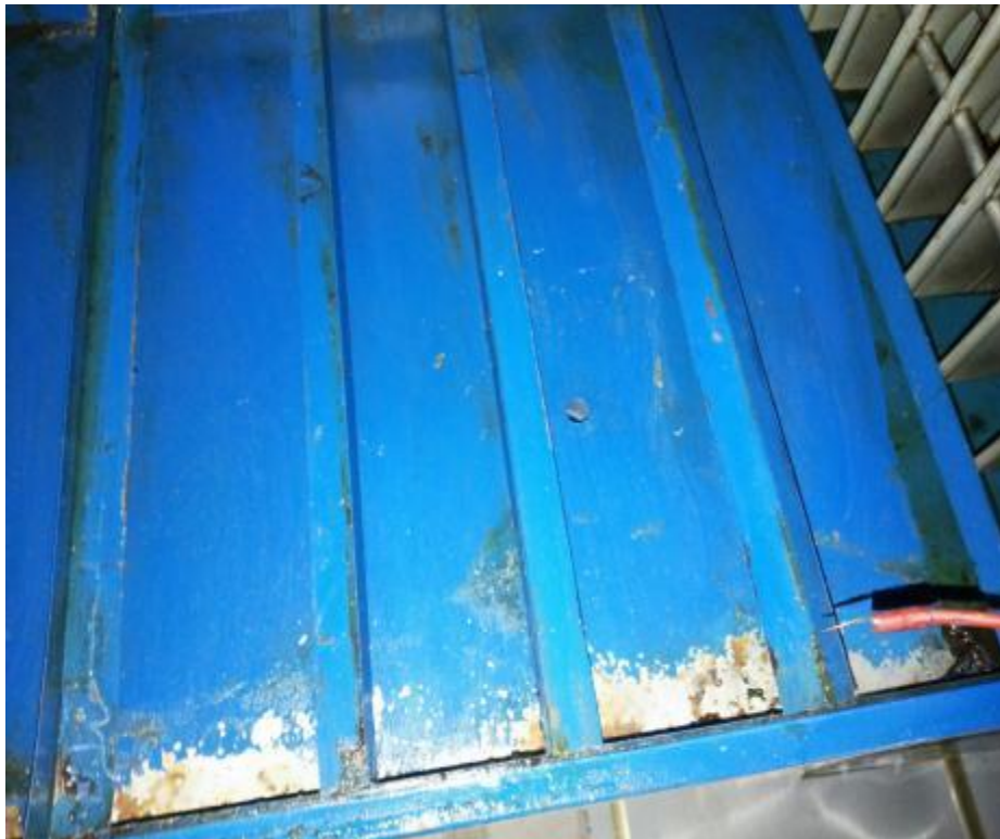
净化器内部清洗后
